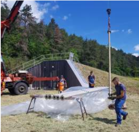
Erhalt der eigenen Trinkwasserversorgung Erneuerung der Brunnenpumpe am „Katzelbrunnen“
