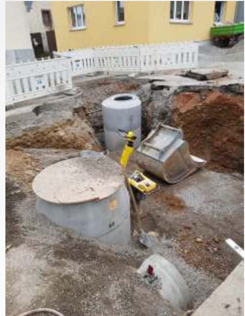
Bauarbeiten in Tiefenthal Wasser und Kanal sowie Erneuerung der Hausanschlüsse
