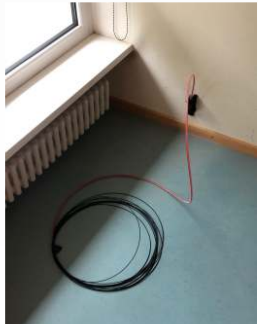
Glasfaser ist in der Schule angekommen Jetzt fehlt nur noch die Verkabelung im Haus... dann ist unsere Grundschule im digitalen Zeitalter angekommen. Tablets liegen schon im Rathaus bereit. Sie müssen noch registriert und installiert werden.
